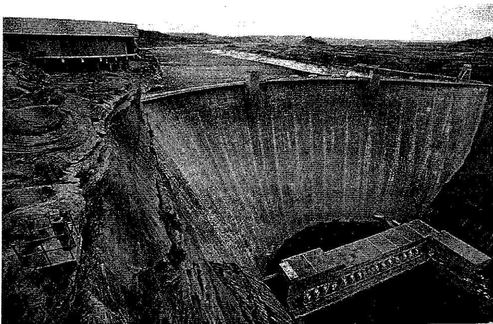
Hình 1.5. Đập thủy điện "Glen Canyon" tại Arizona – USA
