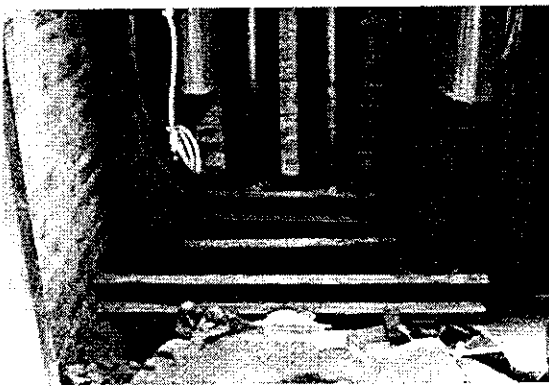
Hình 1.9: Hộp kỹ thuật cho ống cấp nước
