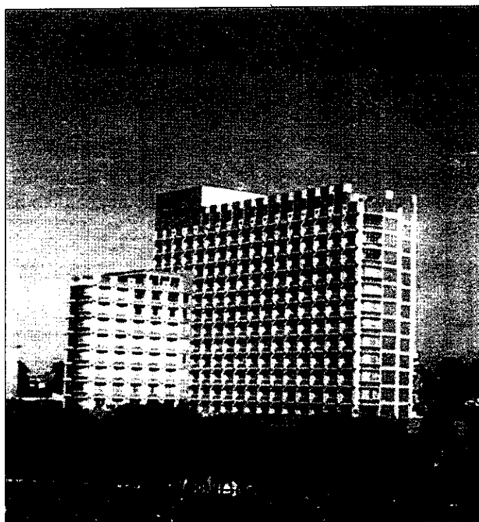
Hình 6.4. Kết cấu che nắng hỗn hợp. Khách sạn New World ở TP. HCM
